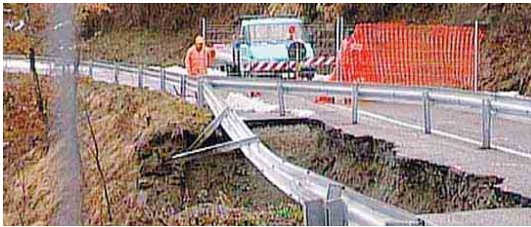
La frana sulla strada provinciale 486 nel territorio del Comune di Frassinoro
